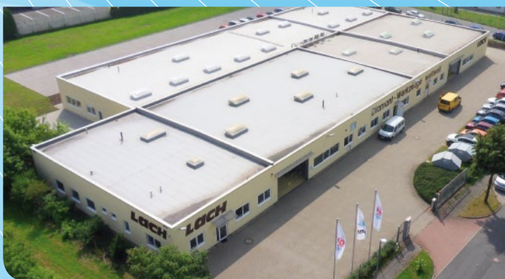
Werk Sachsen / Plant Saxonia Lichtenau/Chemnitz
