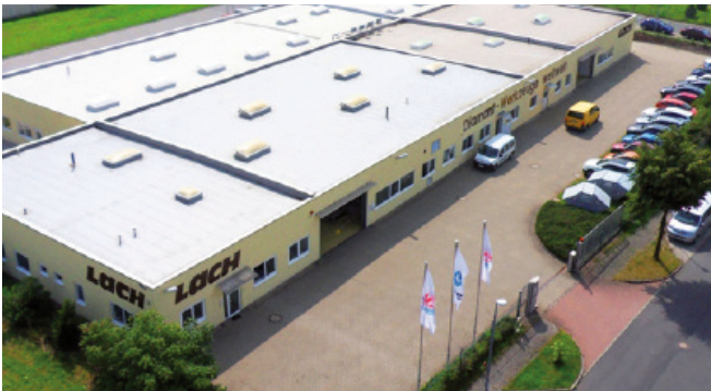
Werk Sachsen / Plant Saxonia Lichtenau/Chemnitz
