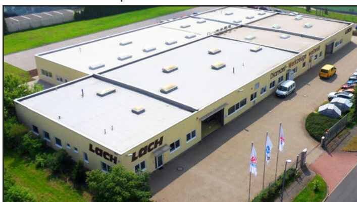
Werk Sachsen / Plant Saxonia Lichtenau/Chemnitz
