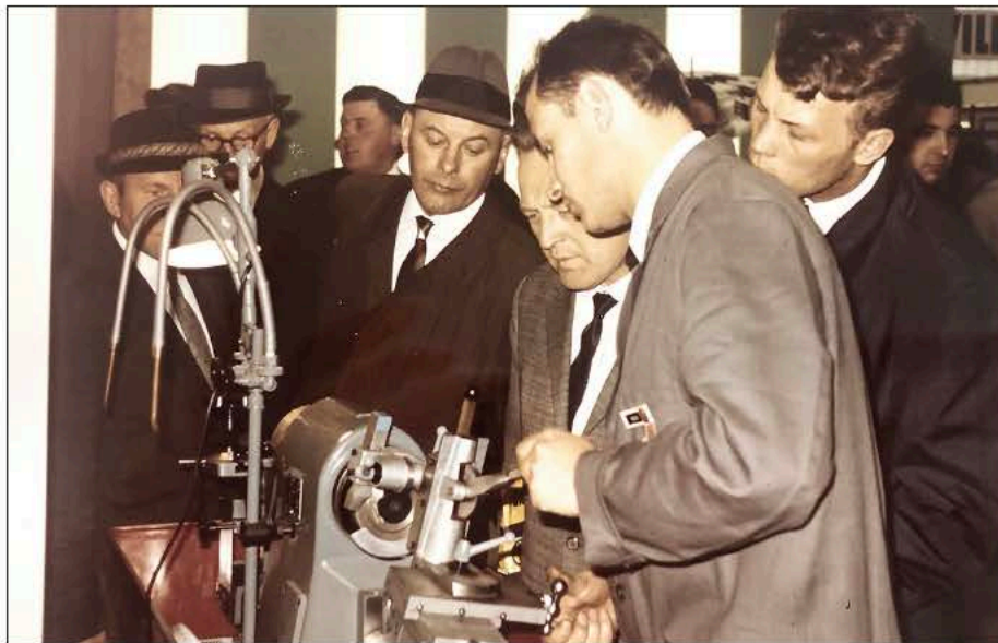
Karl Ruth demonstriert auf der Hannover Messe 1968 einem staunenden Fach-Publikum das Schleifen mit der neuentwickelten kunststoffgebundenen Diamant-Schleifscheibe Bindung K-MC mit metallüberzogenem Diamant-Korn auf einer Simon-Stähle-Schleifmaschine.
