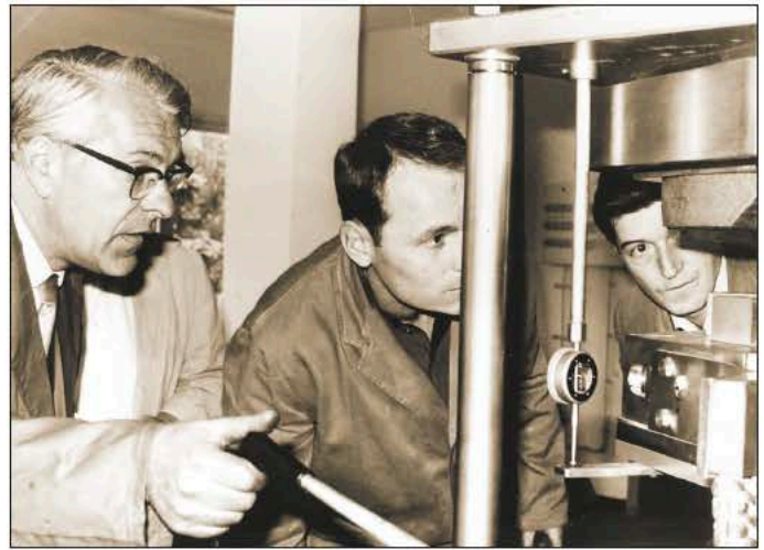
Dr. Fritsch (Inh. der gleichnamigen Firma) nimmt die erste Diamant-Schleifscheiben-Pressen – eine Druck-Sinter-Anlage – persönlich in Betrieb (aufgenommen ca. 1963).
