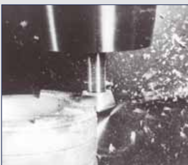
1974 LACH DIAMANT demonstriert auf der Hannover Frühjahrmesse erstmals das Fräsen mit PKD von Kunststoffen und Aluminium (im Bild Zerspanung von GFK).
