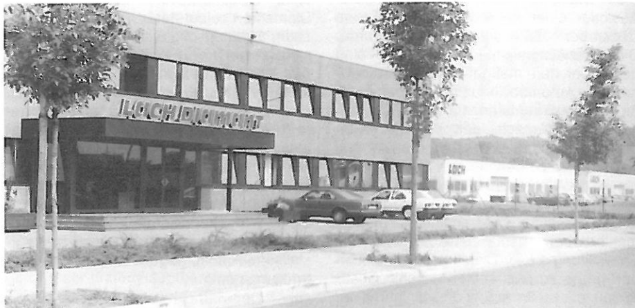
Abb. 1: Seit drei Jahren befinden sich die Verwaltung und Fertigungsstätten der Jakob Lach GmbH & Co. KG in der Hanauer Donaustraße
